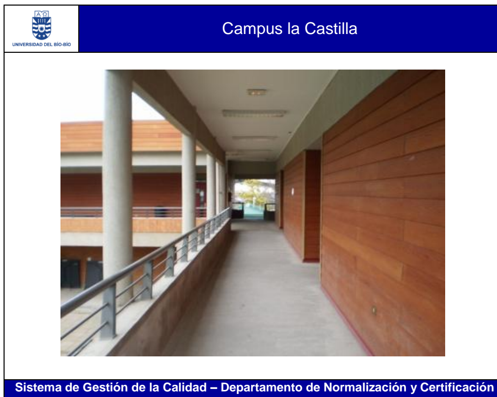
Pasillo aulas nuevas Campus La Castilla (vía de evacuación).
